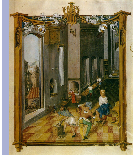
La carpintería, en Balthasar Behem Codex, ca. 1505, Biblioteca Jaguelónica, Cracovia, Polonia.
